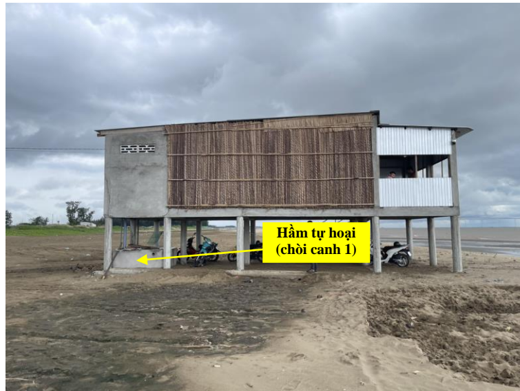
Hình 11: Hầm tự hoại được xây dựng tại chòi canh 1
