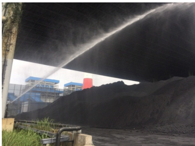
Phun nước dập bụi tại kho than
