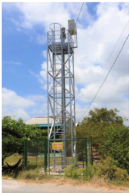
Hệ thống trạm quan trắc không khí tự động (01 trạm chính và 01 trạm phụ) (nguồn: Lâm Quang Trung)
