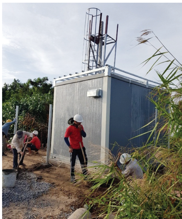
Thi công Trạm Quan trắc khu vực xã Dân Thành
