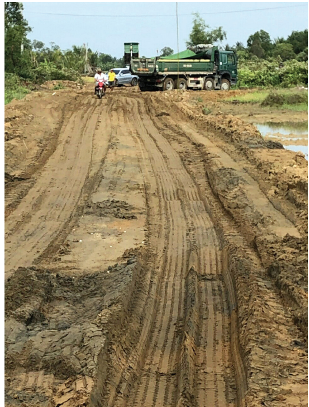
Thi công công trình Hạ tầng thiết yếu phục vụ vùng sản xuất cây ăn trái tập trung tại thành phố Trà Vinh, tỉnh Trà Vinh.
