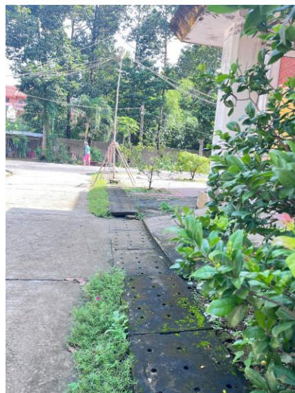
Hình 5. Hệ thống thu gom nước mưa chảy tràn
