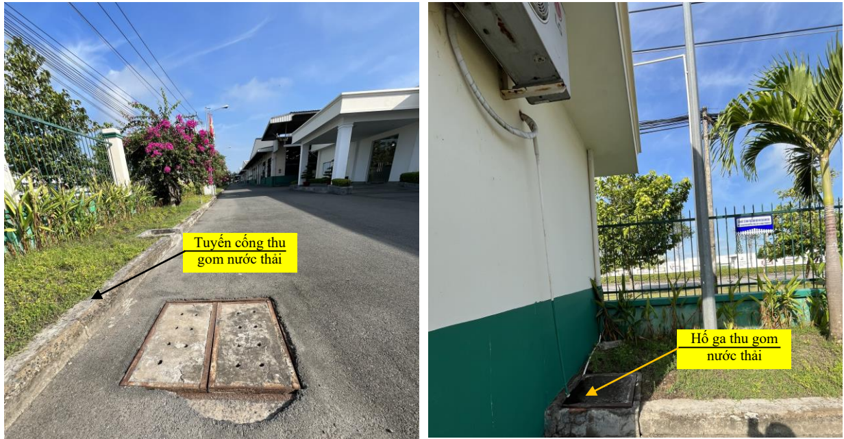
Hình 9. Tuyến công và hố ga thu gom nước thải
