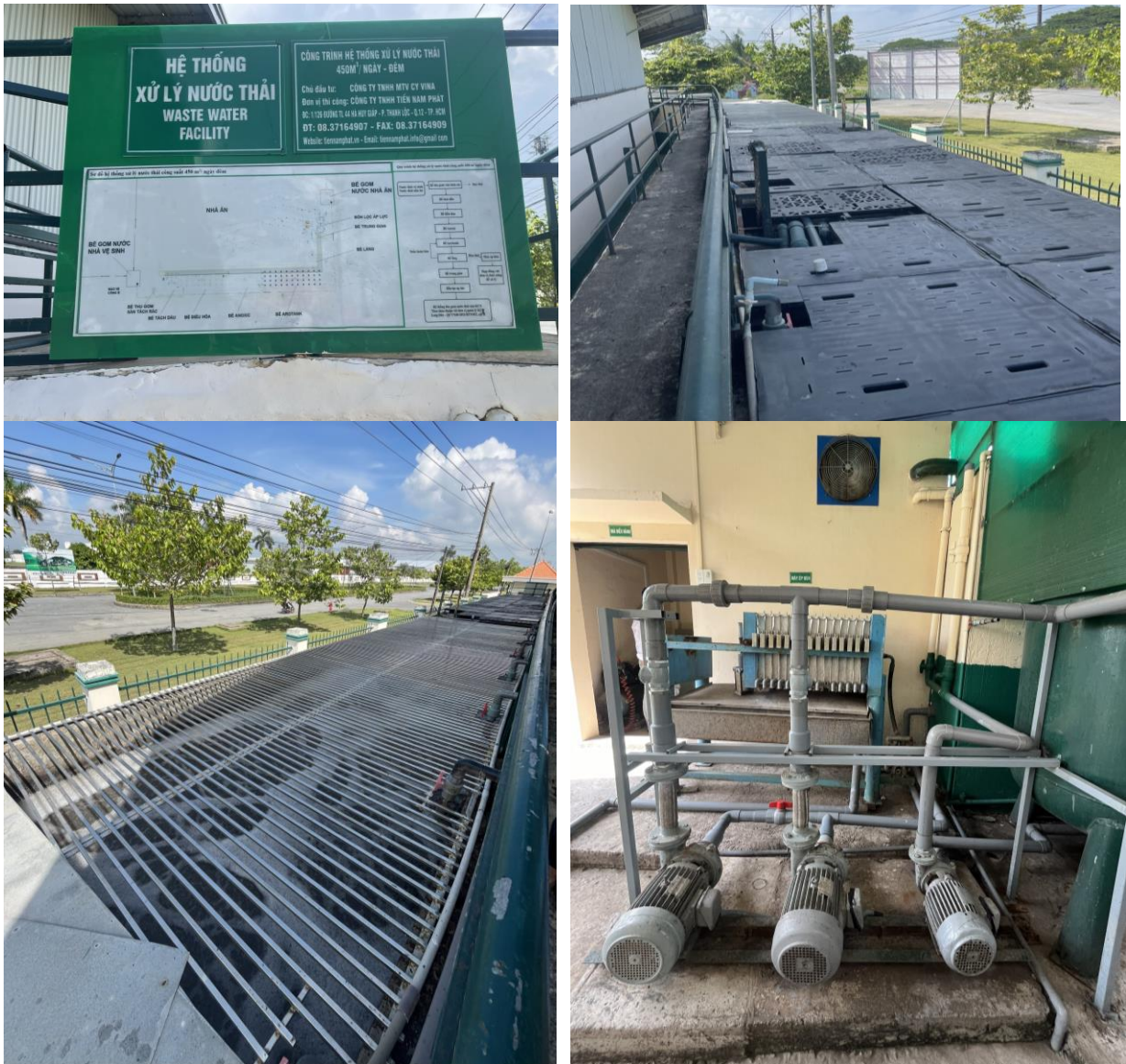
Hình 12. Hệ thống xử lý nước thải tập trung, công suất 450 m 3 /ngày đêm
