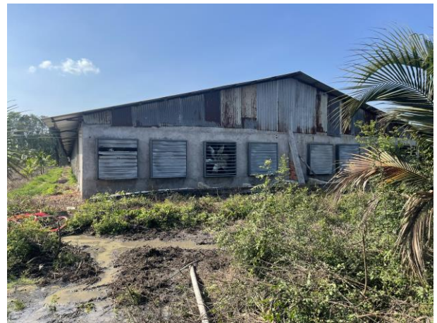
Hình 18. Quạt hút (dây chuồng 2)
