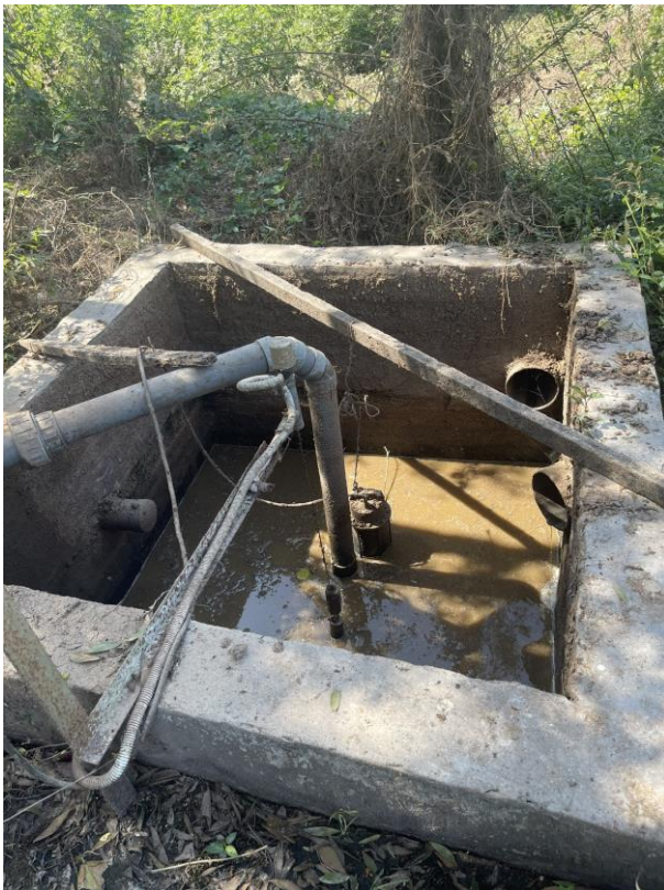
Hình 9. Hồ thu gom nước thải
