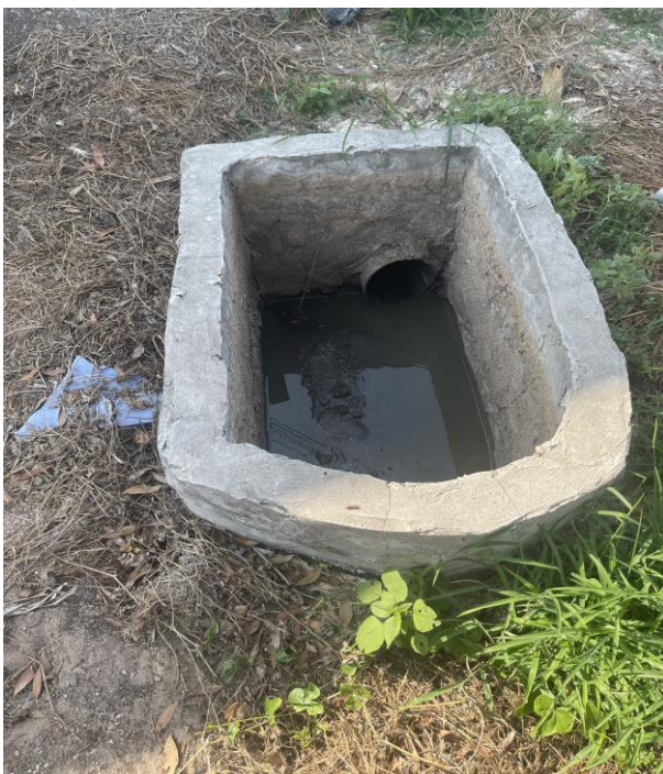
Hình 7. Hồ ga nước thải cuối dãy chuồng nuôi
