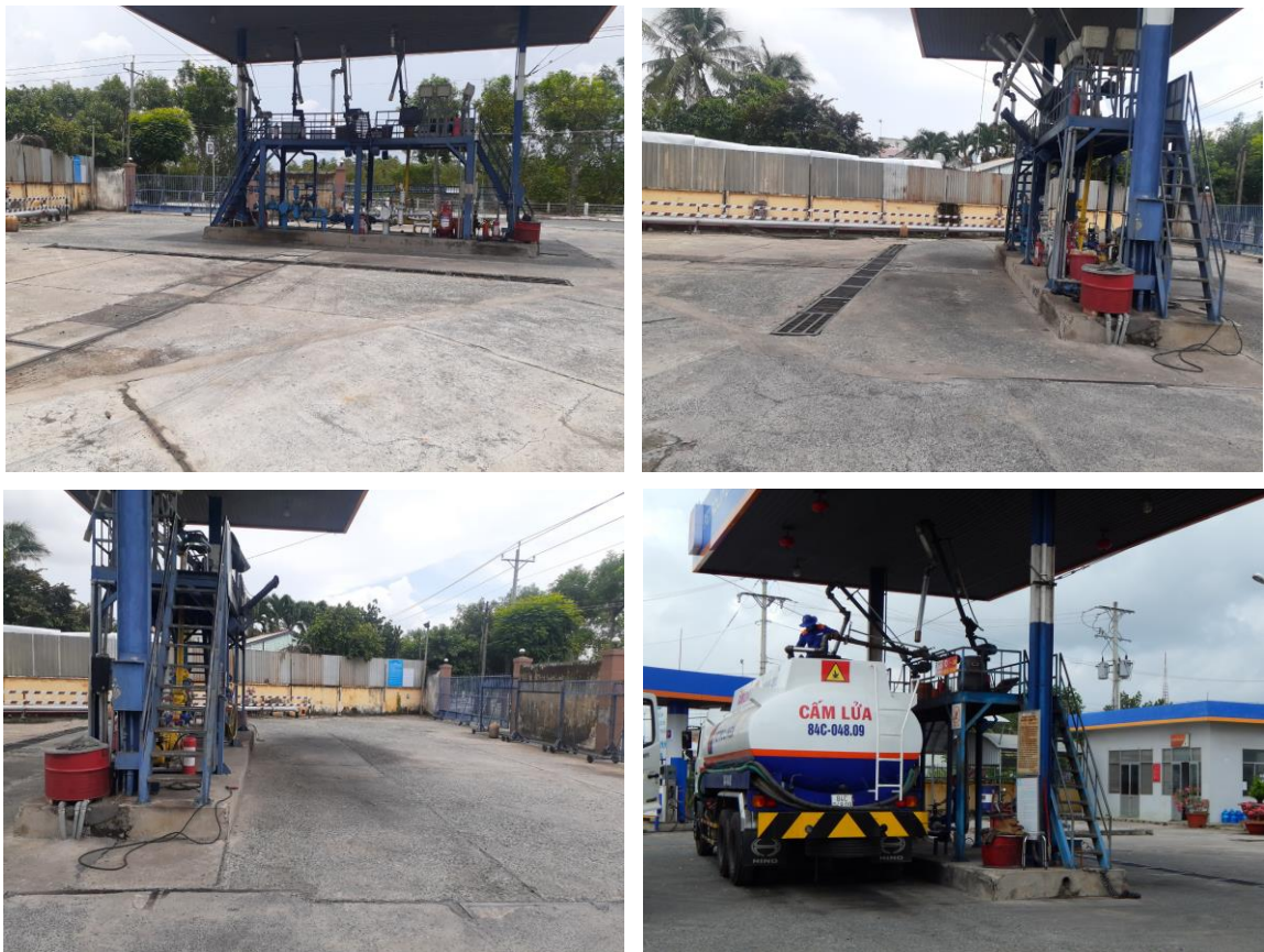
Hình 6. Bến xuất xăng dầu cho xe xitec
