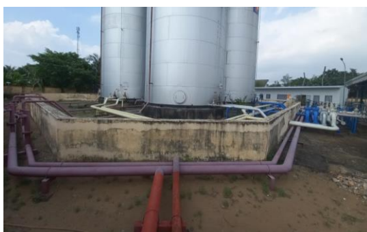
Hình 7. Bể chứa nước và ống công nghệ PCCC
