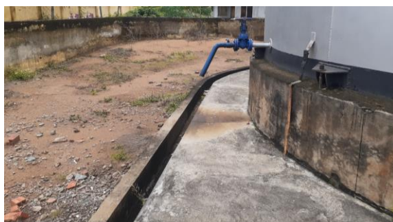
Hình 8. Rãnh, hố ga, hố lắng tách sơ bộ nước thải nhiễm dầu
