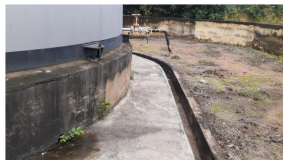
Hình 8. Rãnh, hố ga, hố lắng tách sơ bộ nước thải nhiễm dầu
