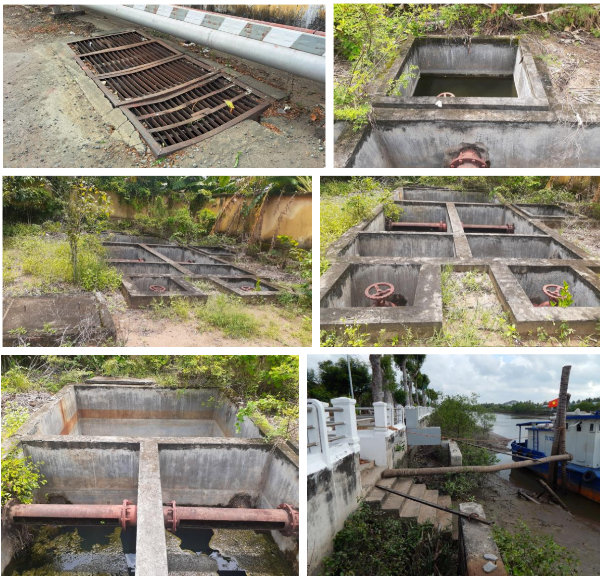
Hình 9. Hồ thu gom, bể xử lý nước thải nhiễm dầu, vị trí tiếp nhận xả thải
