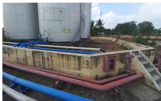
Hình 7. Bể chứa nước và ống công nghệ PCCC
