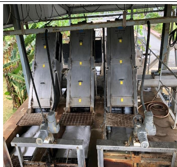
Công trình tách rác
