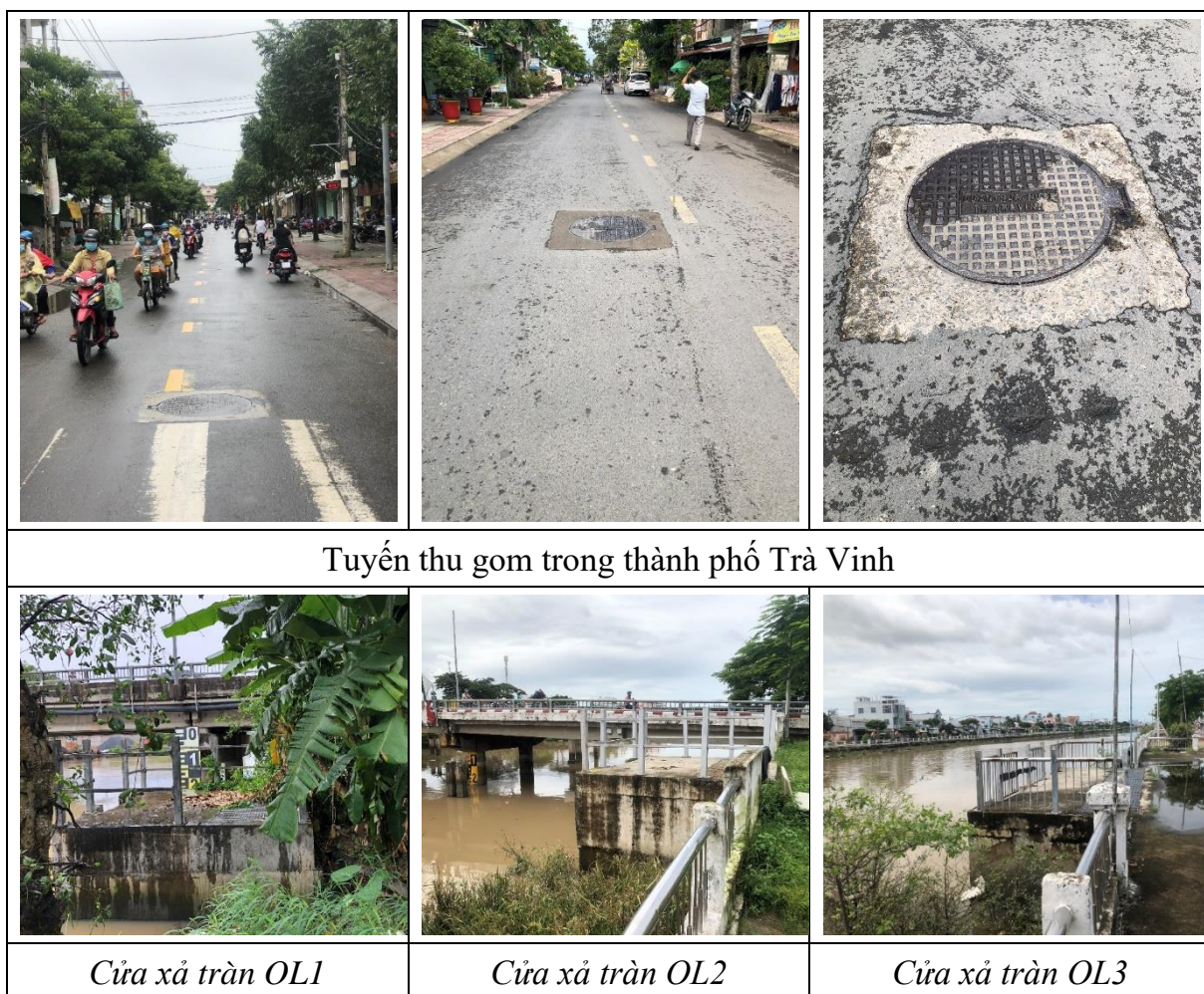
Hình 1.2: Một số hình ảnh 03 cửa xả tràn OL1, OL2, OL3 tại dự án
