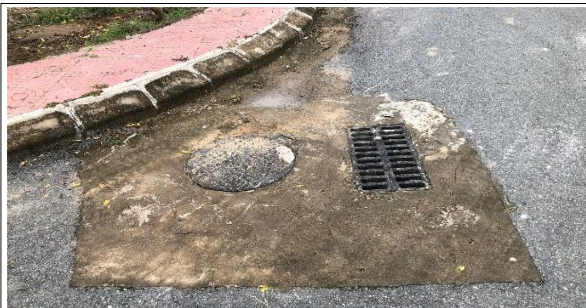
Hệ thống thu gom nước thải tại nhà máy
