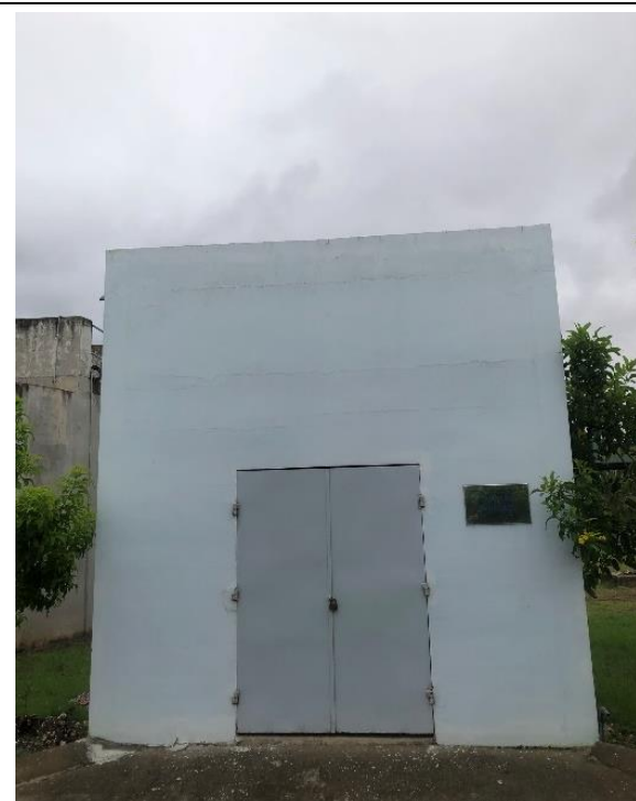
Trạm bơm bể nén bùn
