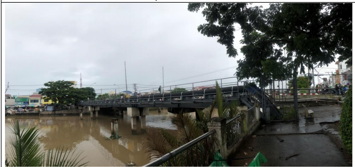
Đường ống áp lực dẫn nước thải từ trạm bơm PS1, PS2 băng sông Long Bình
