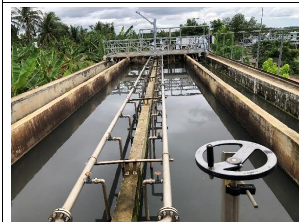
Bể lắng cát
