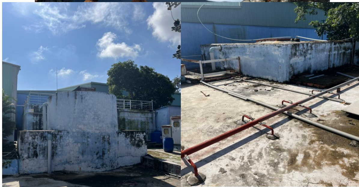
Hình 7. Hệ thống xử lý nước thải tập trung tại Cơ sở
