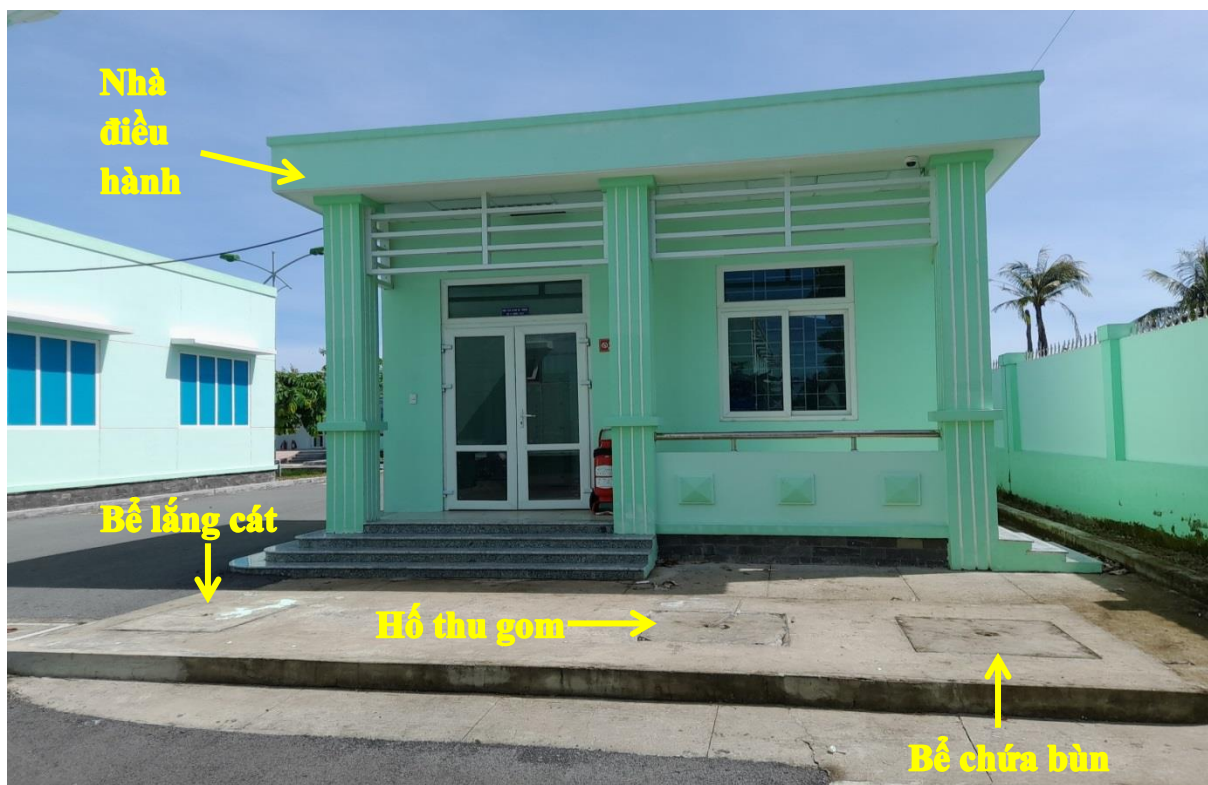
Hình 12: Khu vực bể lắng cát, bể thu gom và bể chứa bùn
