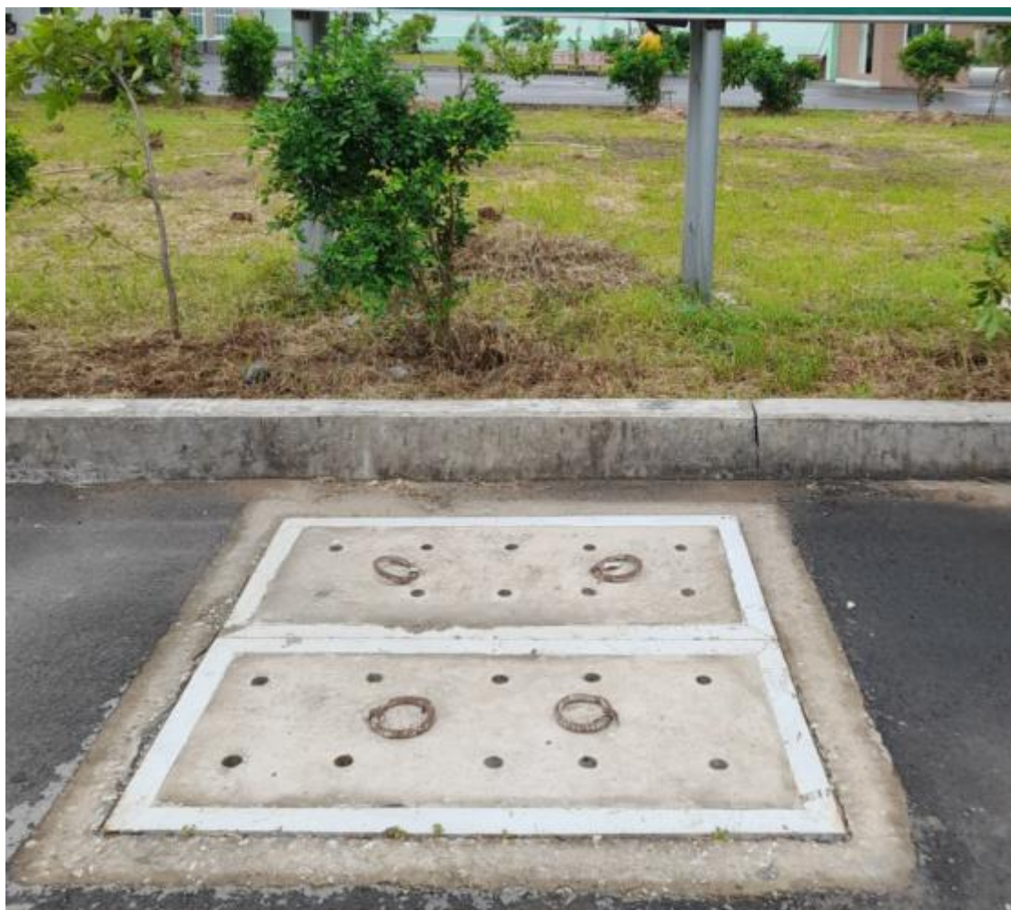
Hình 6: Hố ga thoát nước mưa trước khi chảy vào giếng tự thấm
