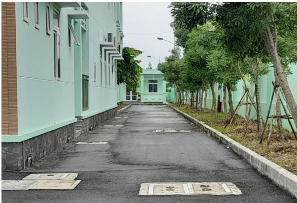
Hình 5: Tuyến thoát nước mưa cạnh khối nhà hành chính – khoa dinh dưỡng
