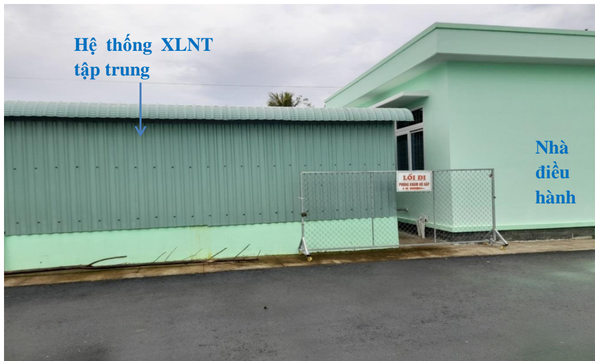
Hình 11: Vị trí lắp đặt hệ thống XLNT tập trung
