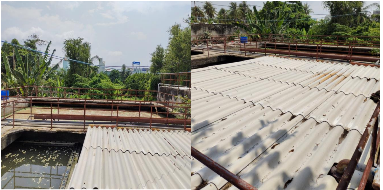
Hình 12. Mái che tại khu vực bể điều hòa
