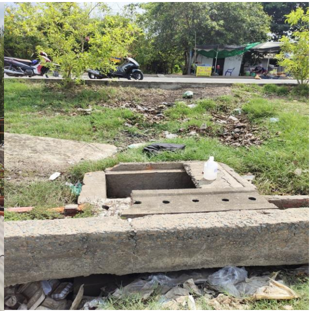
Hố ga nước thải sau xử lý
