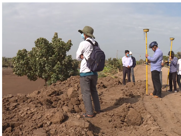
Công tác cắm mốc và đo đạc chi tiết
